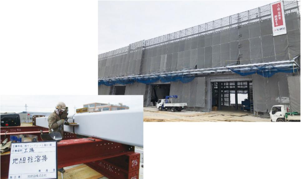
約2万m<sup>2</sup>の広大な敷地を活かし、鉄骨の地組、溶接を地上で行うことで工期短縮を実現しました。土間コンクリートには伸縮目地カッターを幅3mm深さ30mm、4m毎に格子状に施工。
